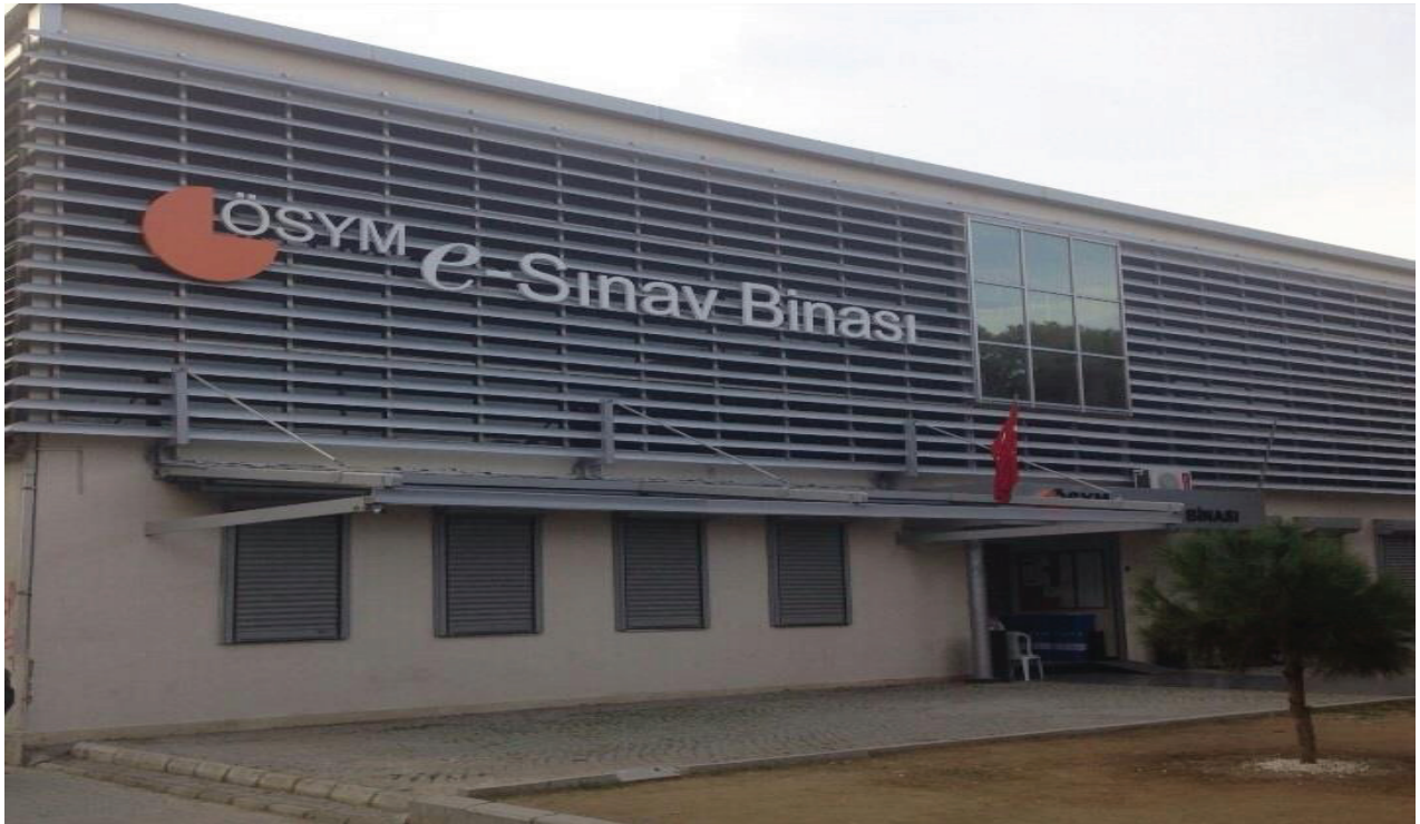
Resim 3- İzmir E-Sınav Binası (Aday işlemleriyle birlikte elektronik sınavların gerçekleştirildiđi 80 aday kapasiteli İzmir koordinatörlük binasıdır.)
